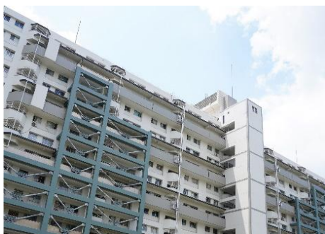
原山台B団地(令和5年度耐震改修実施)
